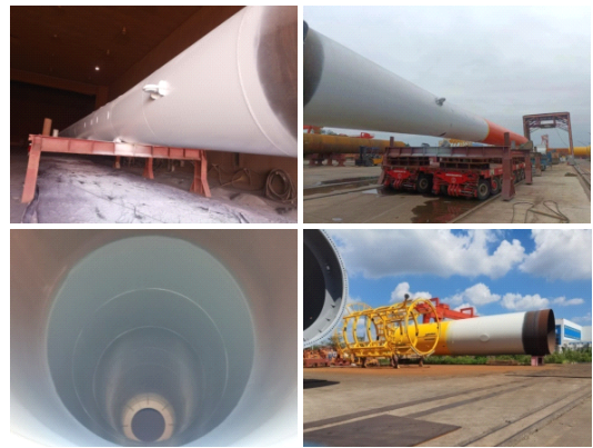
图 5 高固体环氧石墨烯厚浆涂层在钢管桩上的涂装照片
